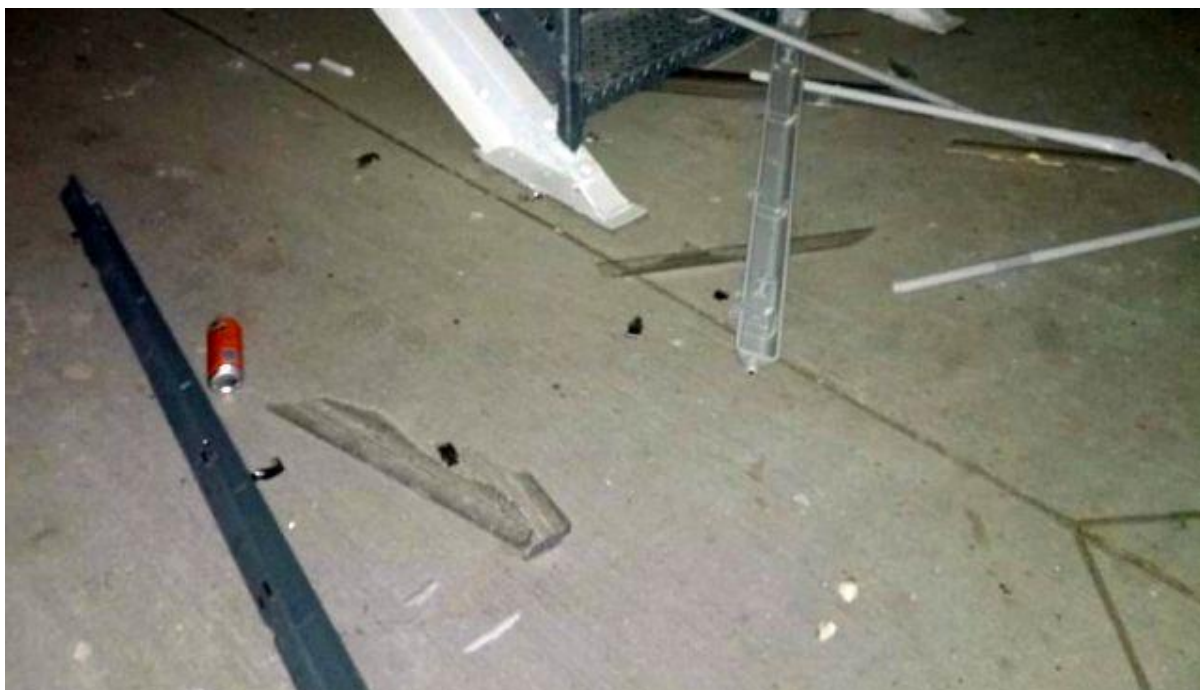
Figura 31 – Vandalizare Fast Park 1 (2)
