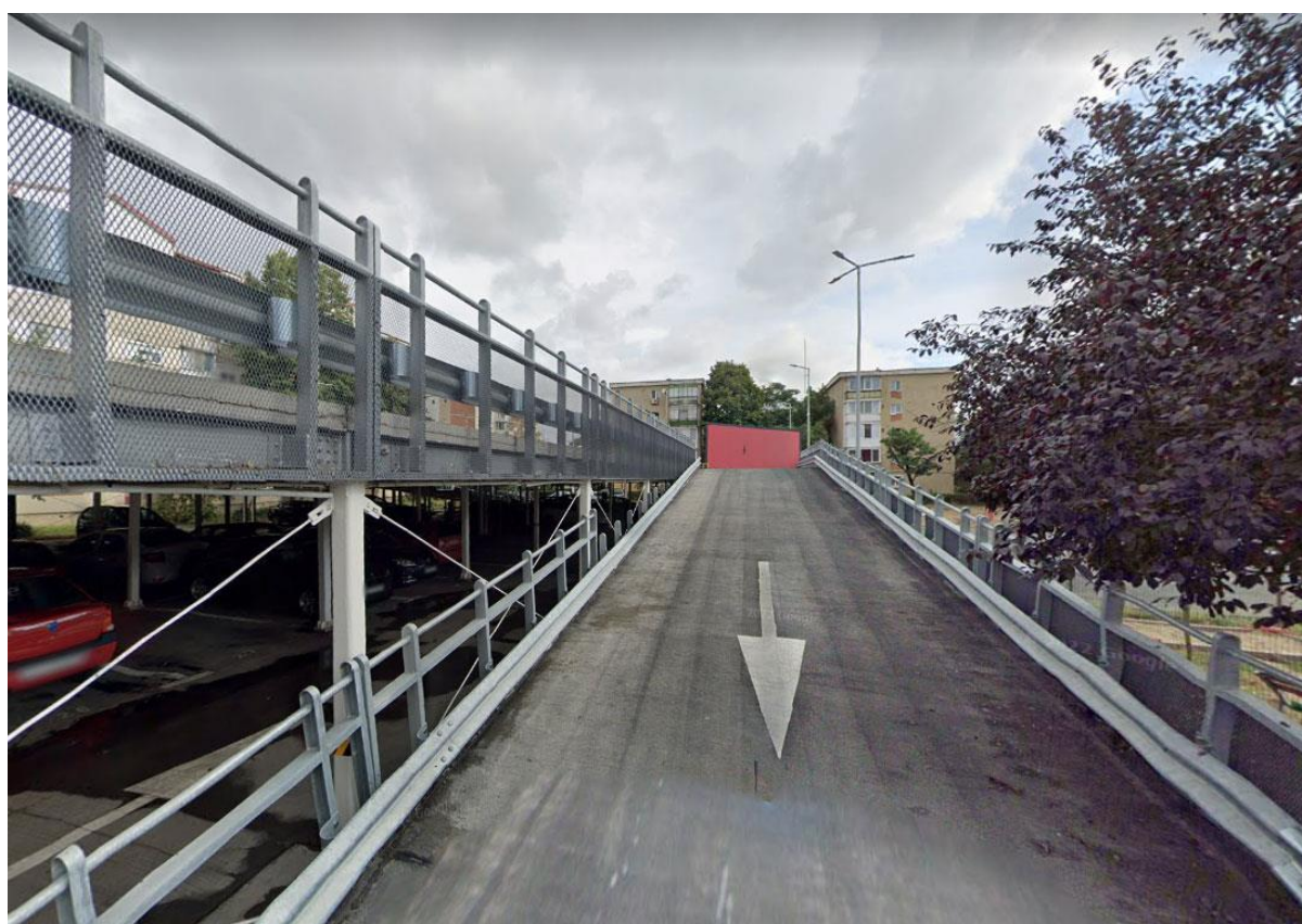
Figura 14 - Rampă acces/coborâre - Fast park 1 - Str. Tunarilor
