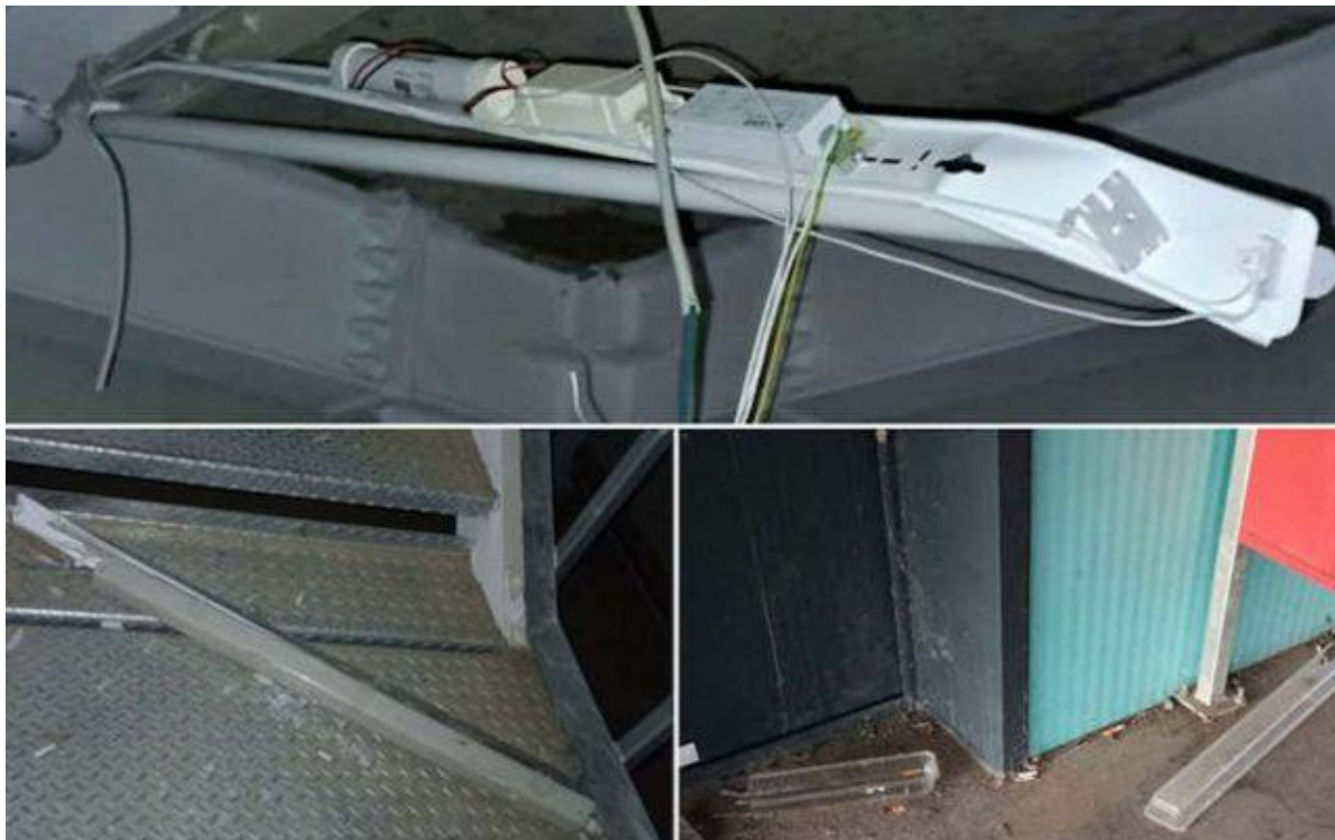
Figura 30 – Vandalizare Fast Park 1 (1)
